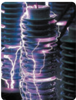
Imagen de descargas en la superficie de un aislador.
