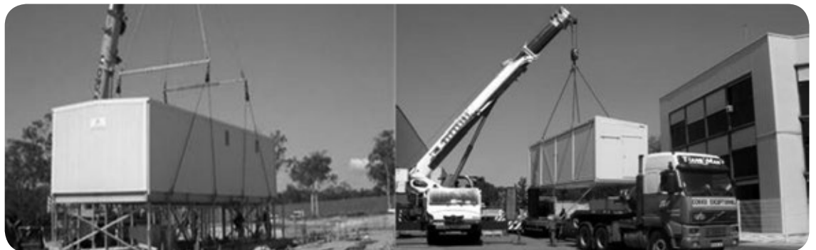
Instalación en sitio
