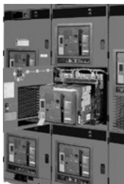
Interruptor NW removido en PZ4
