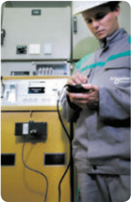
Pruebas de equipos
