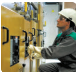
Puesta en Marcha de instalaciones eléctricas
